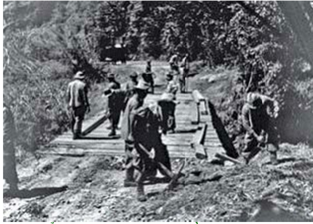
Thổ công binh sửa một cây cầu trên đường 19
